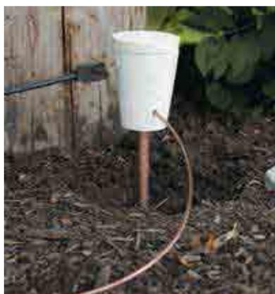
1. Después de preparar el cable y la pica de puesta a tierra, coloque el Cadweld One Shot y conecte el cable a la unidad de control.
