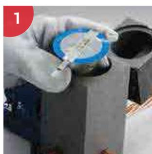
1 Inserte el crisol Cadweld Plus en el molde (puede requerir el uso de una cubierta/deflector)
